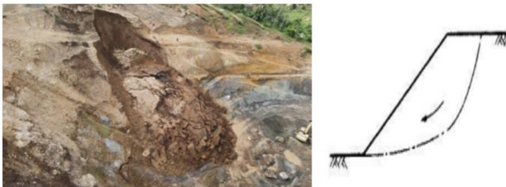
Gambar 3. Tipe longsoran pada sandaran kiri
