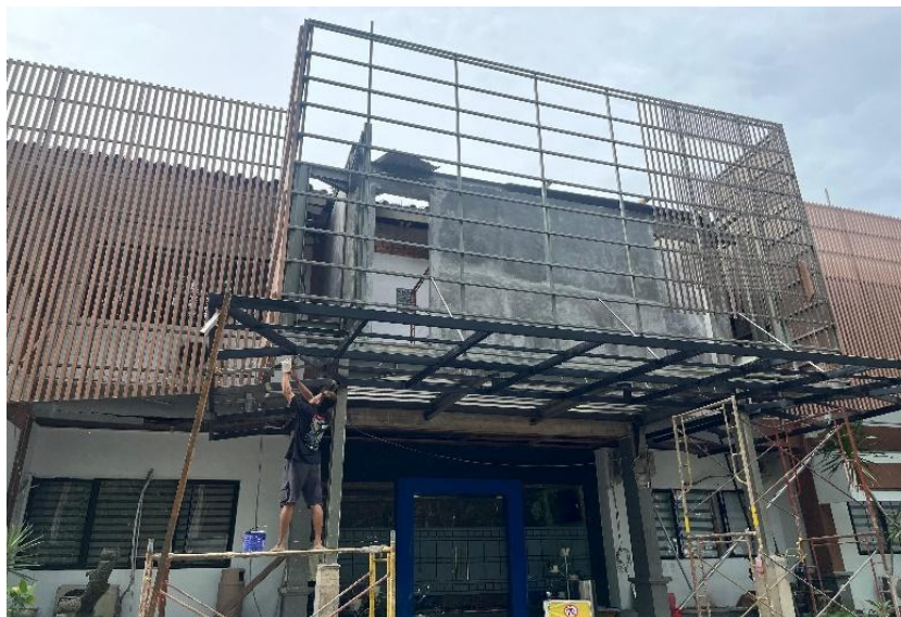
Gambar 2. Proyek Kantor Dinas Pekerjaan Umum Kota Balikpapan
