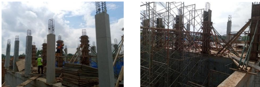
Gambar 4. Bekerja di ketinggian pada konstruksi bangunan Gedung
