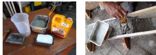
Gambar 4. Pencampuran Lem beton dan Pemberian Lem Beton pada Permukaan yang akan disambung
