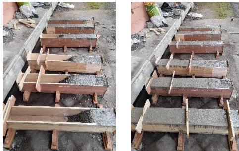
Gambar 3. Hasil Pengecoran Balok Uji
