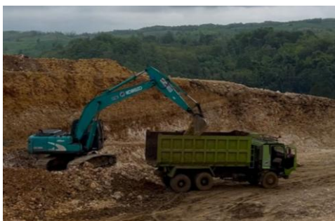
Gambar 3. Dump Truck Dimuat dengan Kobelco SK200 (sumber: dokumen pribadi, 2024)
