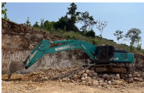
Gambar 2. Excavator Kobelco SK330 (sumber: dokumen pribadi, 2024)
