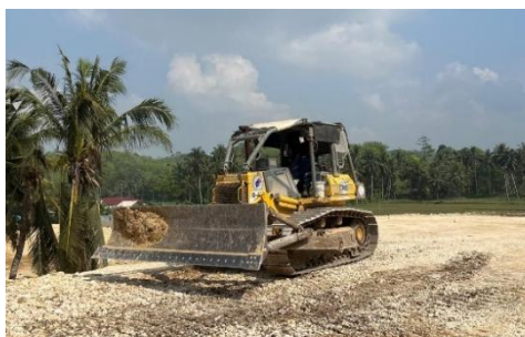
Gambar 5. Bulldozer (sumber: dokumen pribadi, 2024)
