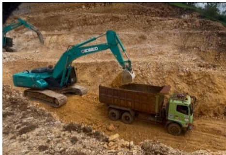
Gambar 4. Dump Truck Dimuat dengan Kobelco SK330 (sumber: dokumen pribadi, 2024)
