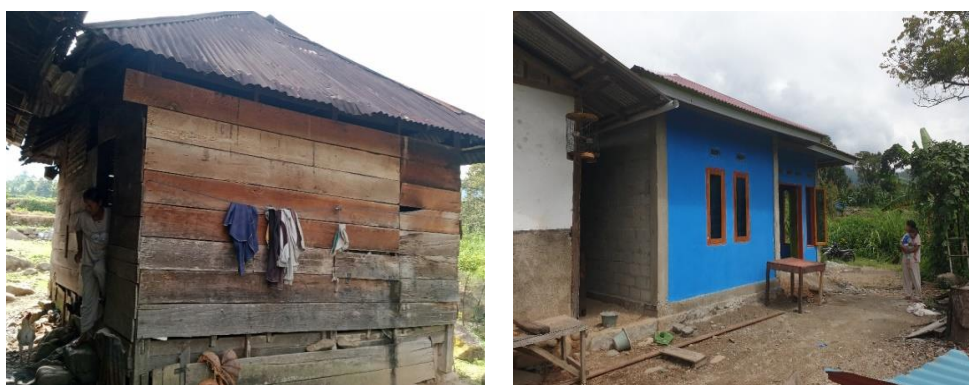
Gambar 8. Rumah penerima bantuan BSPS sebelum dan sesudah dikerjakan
