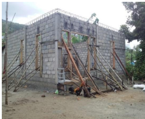
Gambar 6. Rumah penerima bantuan yang dilengkapi pondasi batu kali, sloof, kolom dan ring balok Sumber: Pangestu. Y, 2023 (Dokumen Pribadi)
