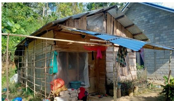
Gambar 1. Rumah dengan struktur bangunan, pencahayaan, sanitasi yang sangat tidak memadai Sumber: Pangestu. Y, 2023 (Dokumen Pribadi)
