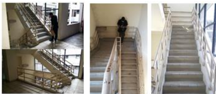
Gambar 20. Kondisi Eksisting Tangga Darurat
