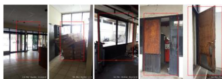
Gambar 30. Titik Pintu Eksit Bangunan Gedung PAU
