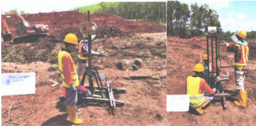
Gambar 4. Lokasi Box Culvert Sta. 4+550 Sumber: Data Olahan (2023)
