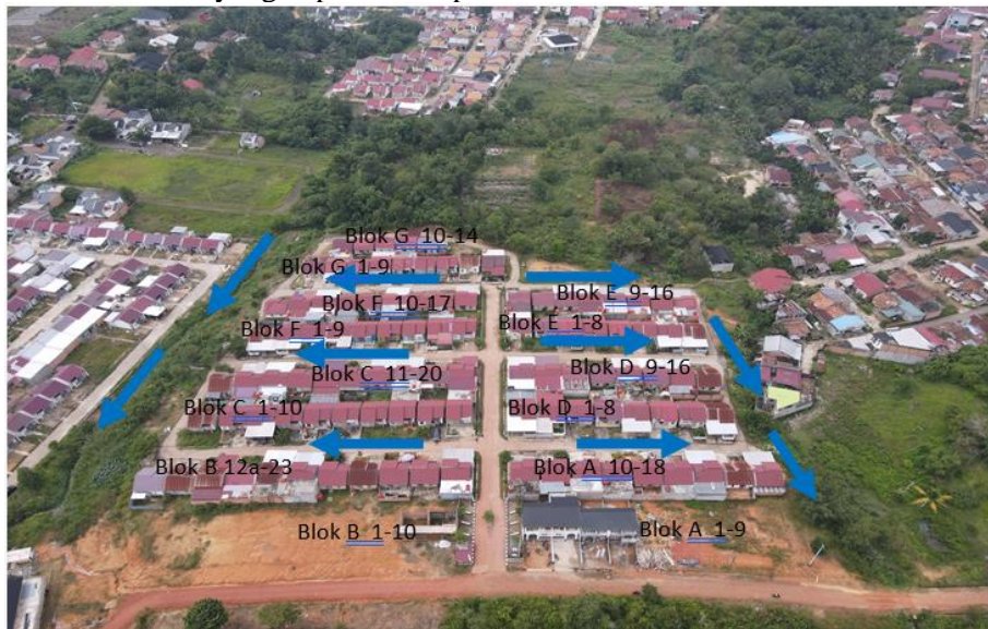
Gambar 2. Jaringan Drainase di Perumahan Villa Delima Mayang
