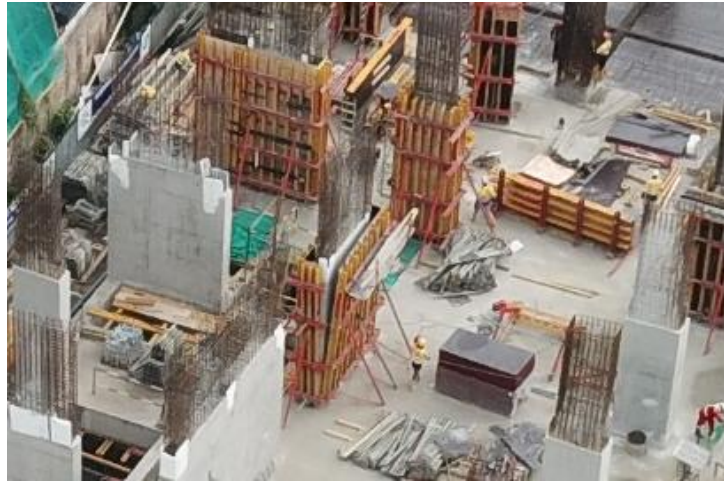
Gambar 3 : Tahap Pengenduran Bekisting
