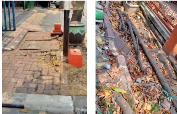
Gambar 4. Kondisi Eksisting Jalur Pedestrian Segmen 3
