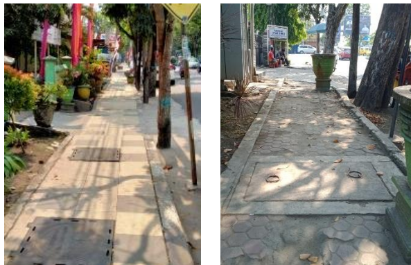
Gambar 2. Kondisi Eksisting Jalur Pedestrian Segmen 1
