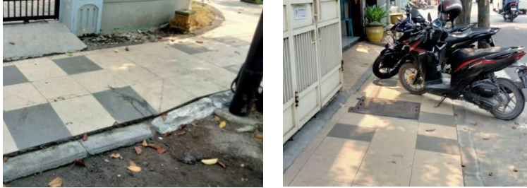
Gambar 3. Kondisi Eksisting Jalur Pedestrian Segmen 2
