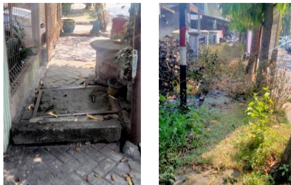
Gambar 5. Kondisi Eksisting Jalur Pedestrian Segmen 4
