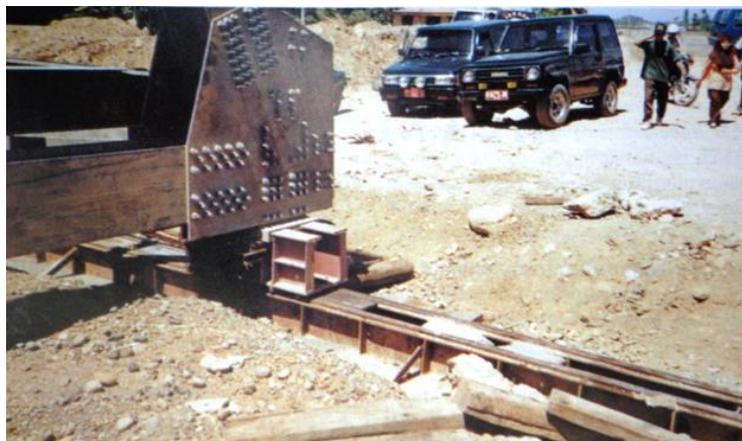
**Gambar 5.** Perletakan jembatan jembatan pada rel untuk proses ereksi
