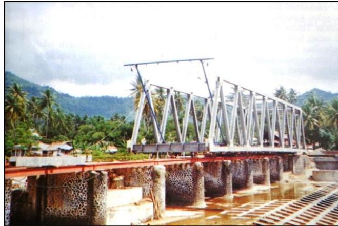
**Gambar 4.** Lokasi perakitan jembatan di atas jembatan lama
