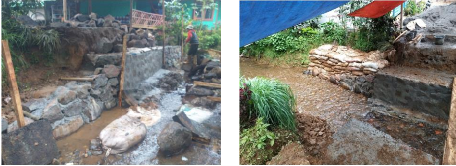
Gambar 7. Pembuatan dinding penahan tanah batu kali dan bronjong
