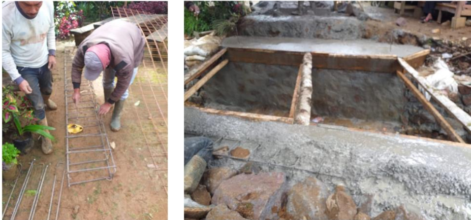
Gambar 8. Pekerjaan Perakitan tulangan sloof dan pengecorannya
