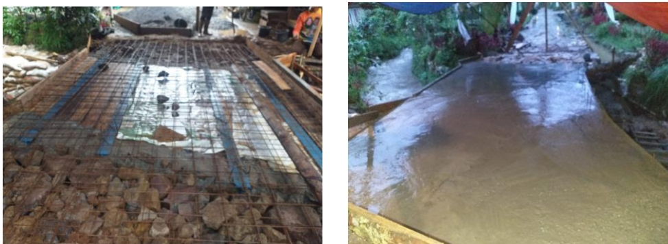
Gambar 9. Pekerjaan perakitan tulangan dan pengecoran pelat lantai
