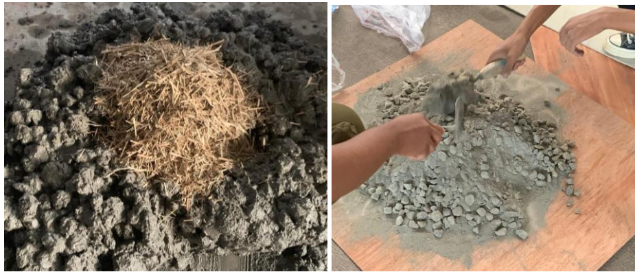
Gambar 2. Proses pencampuran beton
