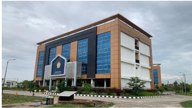
Gambar 1. Tampak Depan Gedung D1 Kampus Keramasan Politeknik Negeri Sriwijaya (Sumber: Dokumentasi Pribadi, 2025)
