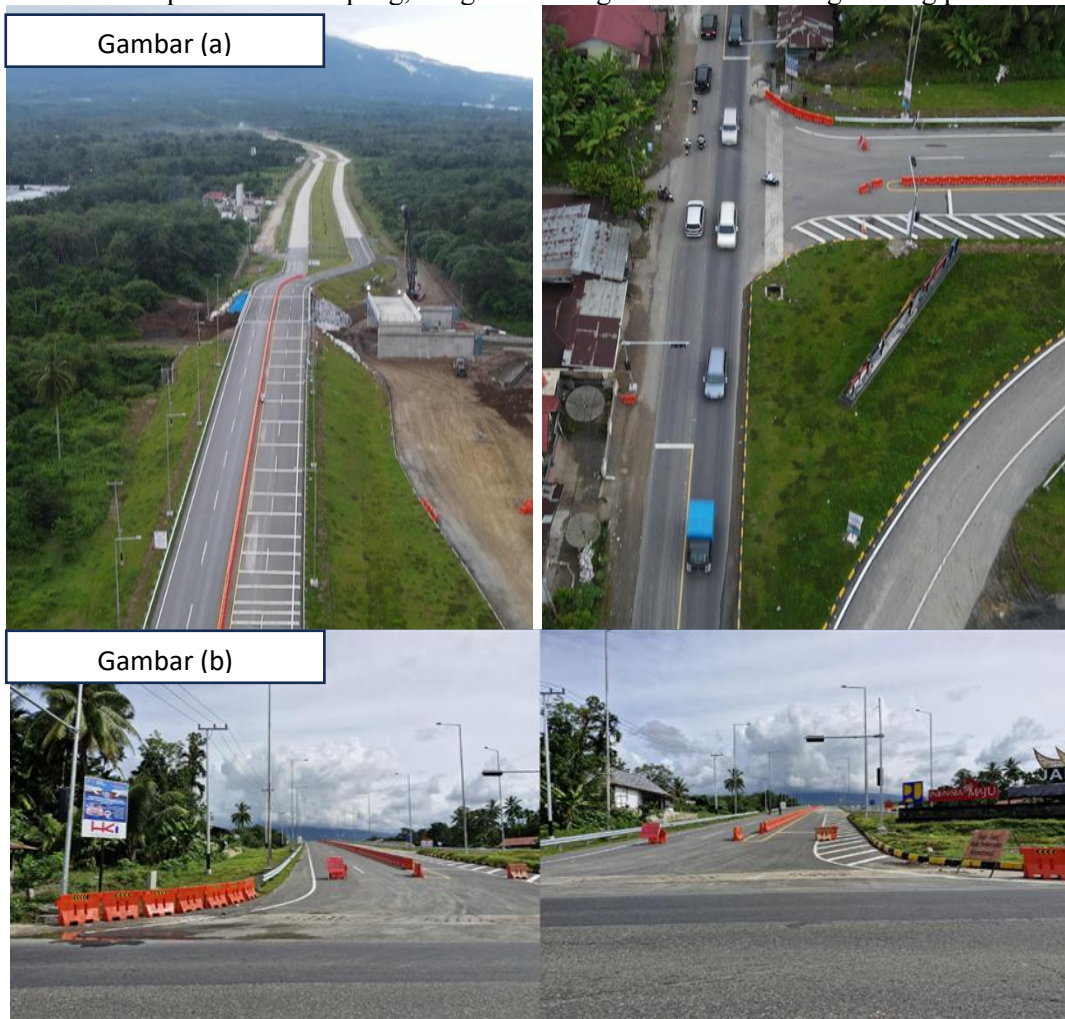
Gambar 3 Kondisi Eksisting Simping Akses Tol Tarok City Tahun 2025
