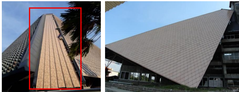
Gambar 6. (Kiri) Penggunaan Atap Baja Ringan Motif Alang-alang. (Kanan) Atap Baja Ringan dengan Warna Coklat Keemasan
