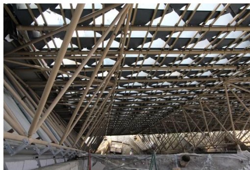
Gambar 7. Struktur Atap Menggunakan Material Baja Ringan
