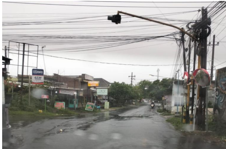
Gambar 3: Genangan pada drainase Sumber: Dokumentasi survei (2025)
