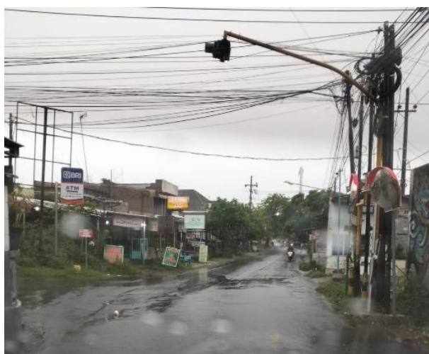
Gambar 2. Kondisi Jalan di Sekitar Universitas Kadiri Saat Hujan Lebat Sumber: Dokumentasi survei (2025)
