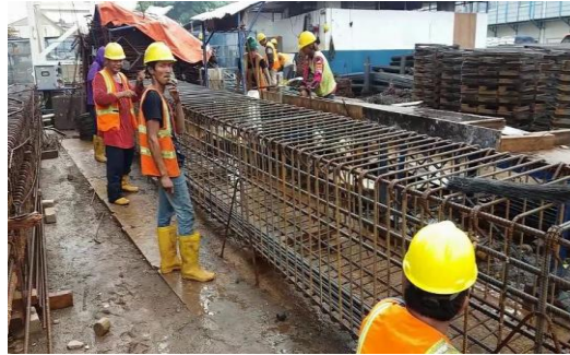
Gambar 4. Perakitan Pembesian Pier
