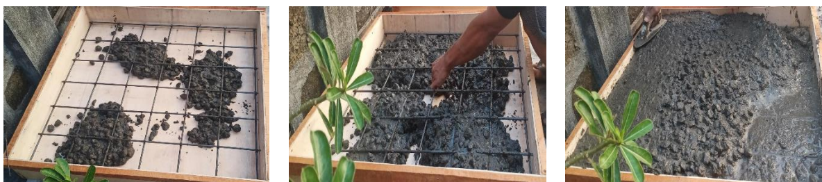
Gambar 8. Pengecoran benda uji pelat lantai
